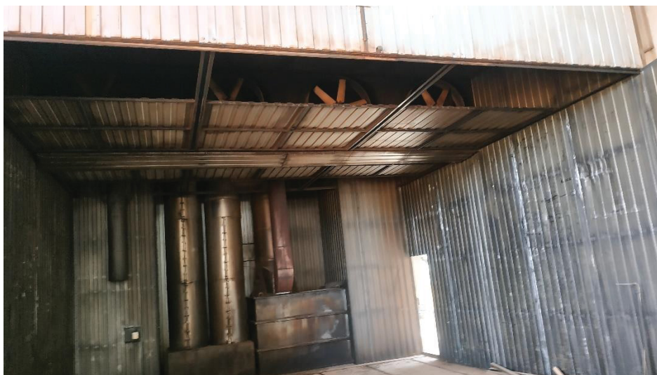
FIGURA 27 - ESTUFA DE SECAGEM ABASTECIDA POR CALDEIRA
