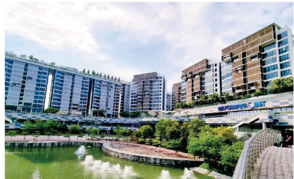
Edifícios residenciais sobre os pavimentos comerciais do shopping Waterway Point
