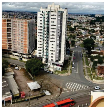
Visão da via estrutural no bairro Capão Raso, com edifícios novos e em construção
