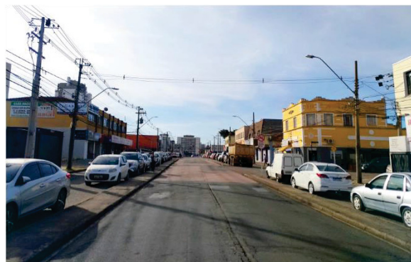
Canaleta da Av. Rep. Argentina, com edifícios comerciais de dois pavimentos
