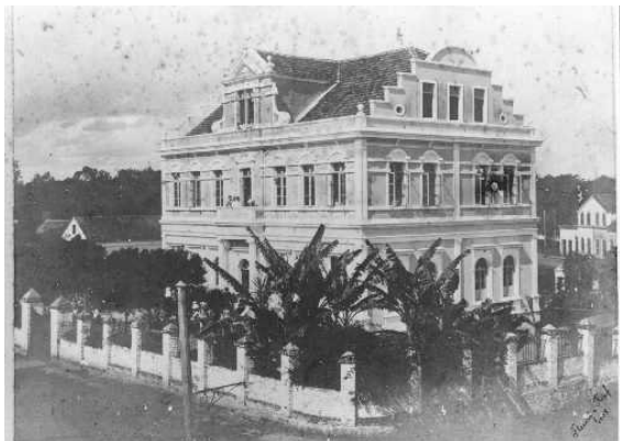
O edifício escolar em 1908, em fotografia de Fleury e Kopf. Acervo da Casa da Memória.
