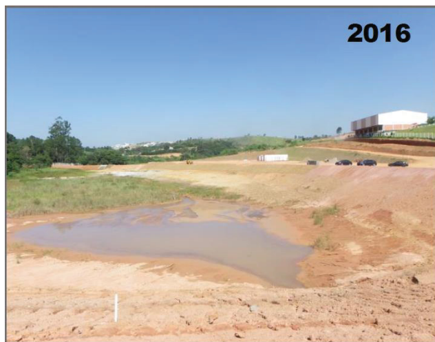
Figura 11 - Implantação de barragem em 2016.
