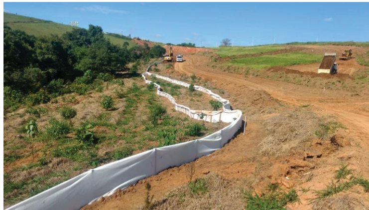
Figura 27 - Manutenção de plantio e obras de implantação do loteamento.
