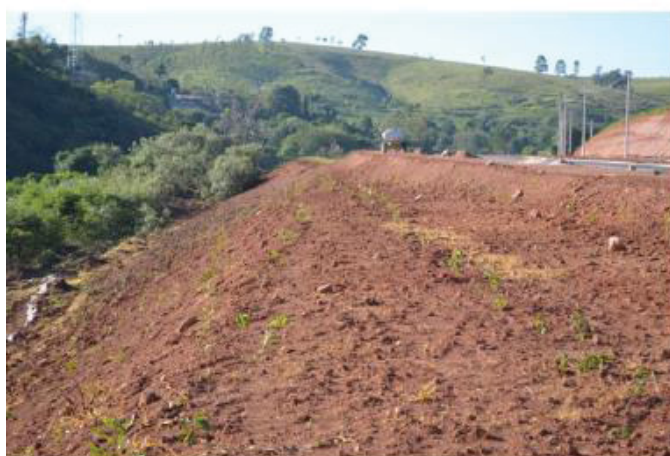
Figura 21 - Execução de plantio em talude. Fonte: Relatório de implantação e manutenção.
