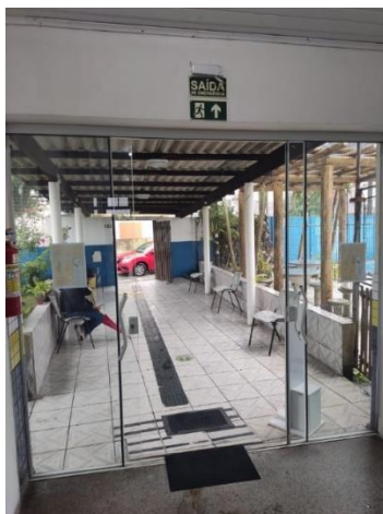
Figura 23 - Saída de emergência
