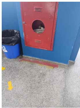
(b) Segundo pavimento
