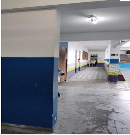
(a) acesso escada para os pavimentos (12.8 m 2 )
