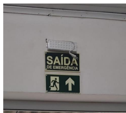
Figura 29 - Luminárias de emergência instaladas
