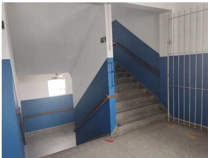
Figura 25 - Vista da escada no 1º pavimento
