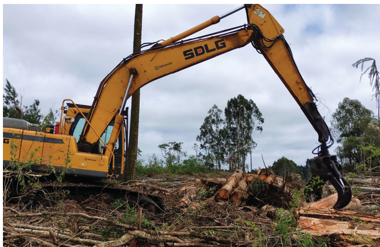
Figura 3. Rachamento de lenha com grua adaptada para esse fim.
