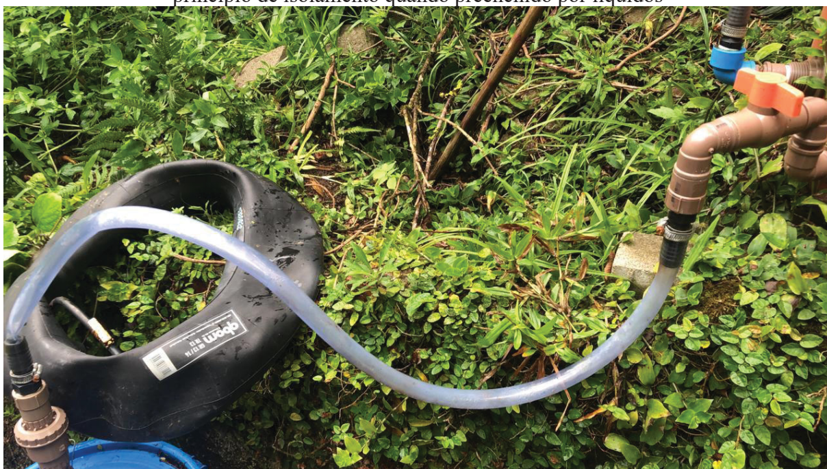
FIGURA 9 - Conexão em “s deitado” entre a composteira e o biodigestor, demonstrando o princípio de isolamento quando preenchido por líquidos
