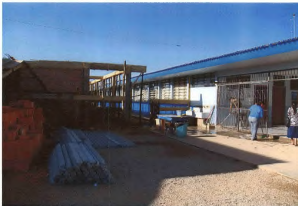
FIGURA 17 – Escola Estadual Fabiana Pimentel em reforma
