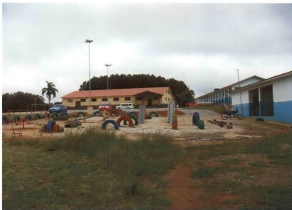
FIGURA 13 - Escola Rural Municipal da Terra Nova, parquinho, estacionamento e Clube Recreativo e Cultural 25 de Julho.
