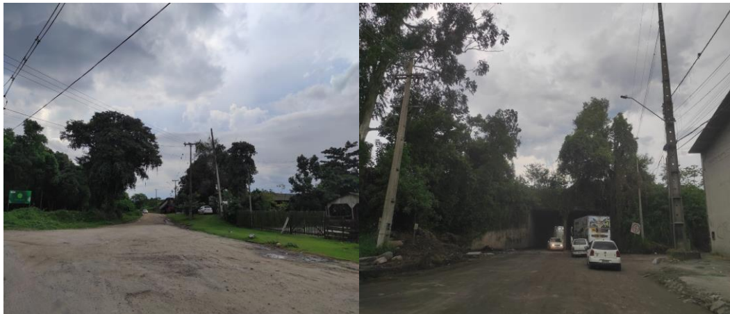
FIGURA 18 – ESTRADA DA FAZENDA DA AREIA E VIADUTO DE ACESSO
