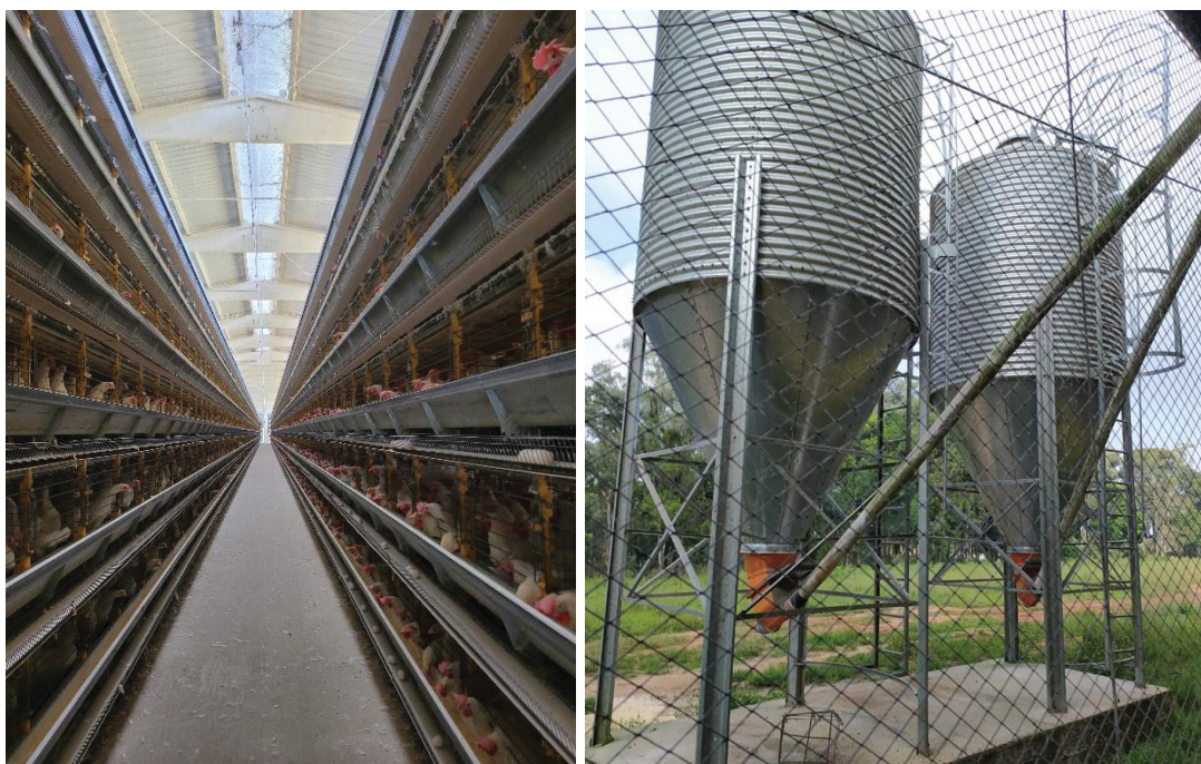
Figura 12 - Área interna do barracão automatizado e Figura 13 - Silos de armazenamento de ração
