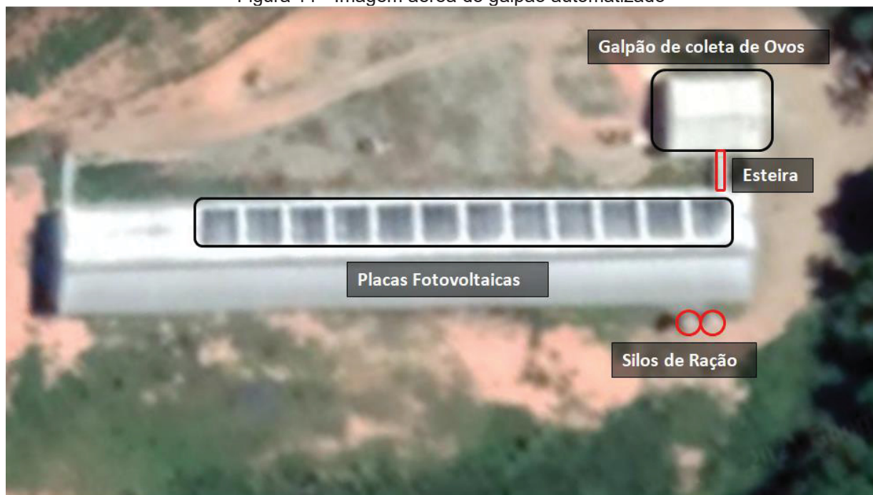
Figura 11 - Imagem aérea do galpão automatizado
