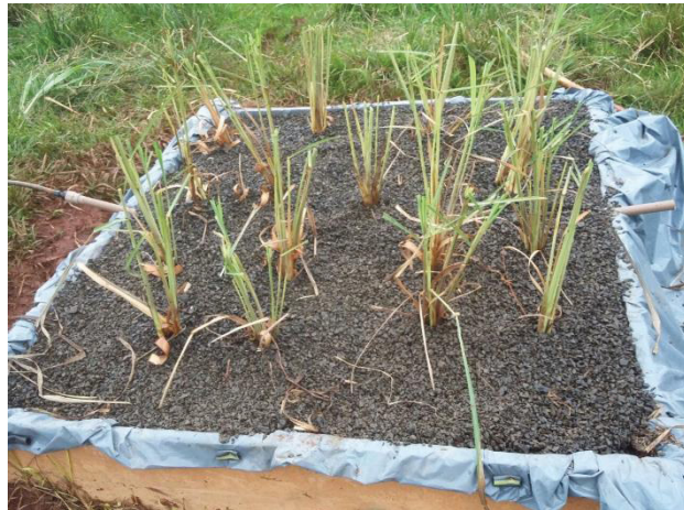
Figura 4 – Zona de raízes instalada
