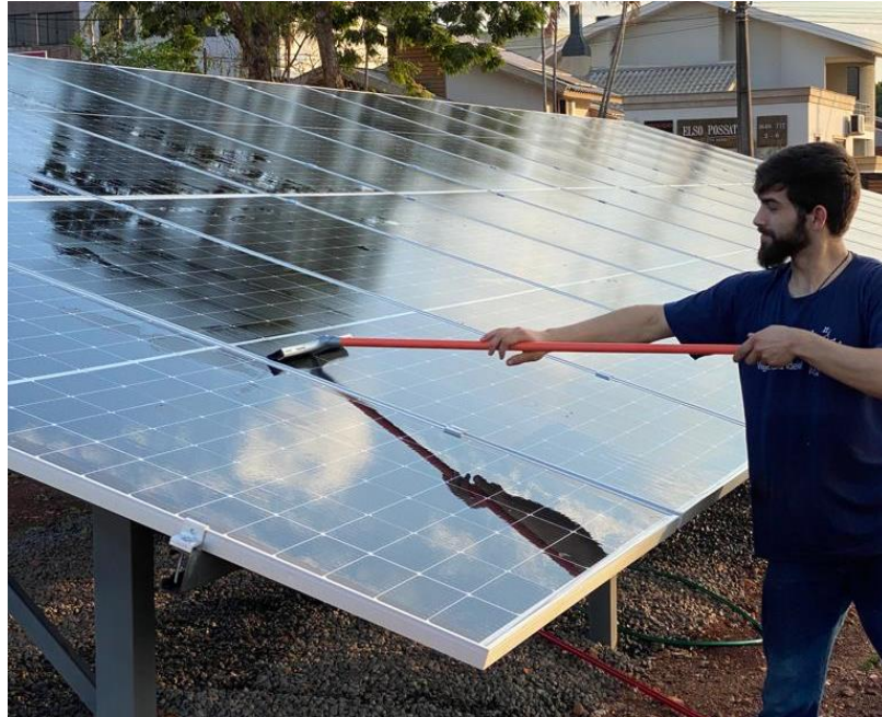
FIGURA 15 – REMOÇÃO DO EXCESSO DE ÁGUA SOBRE A SUPERFÍCIE DOS MFV DA "S1"
