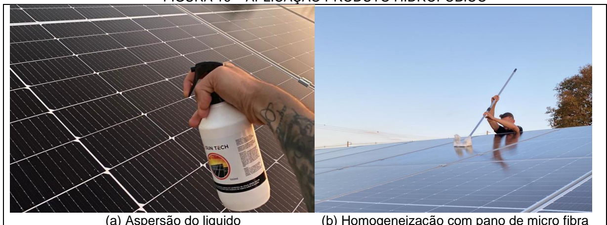
FIGURA 16 – APLICAÇÃO PRODUTO HIDROFÓBICO
