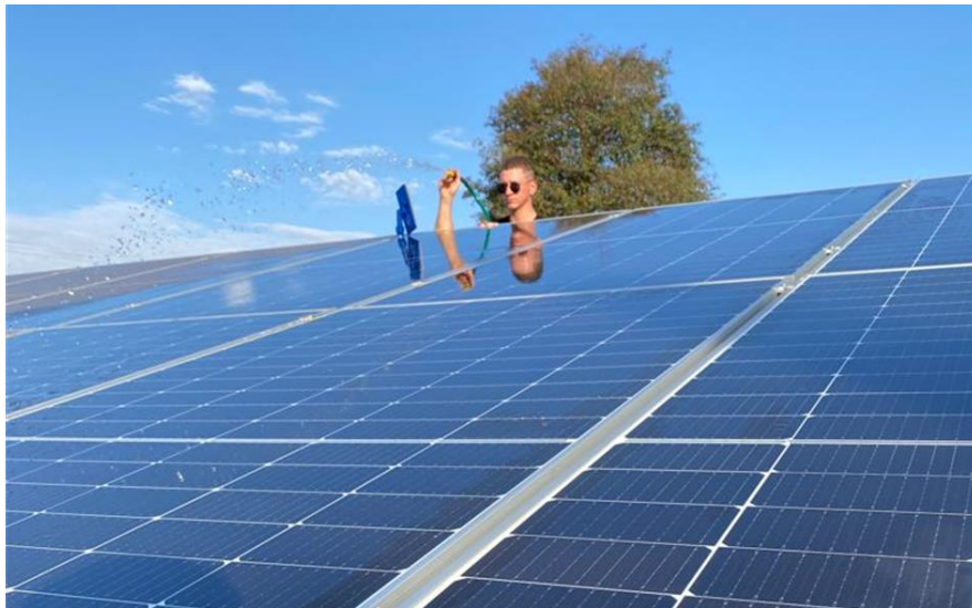
FIGURA 14 – ENXAGUE COM ÁGUA CORRENTE DA “S1”
