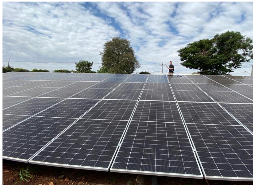
FIGURA 13 – LIMPEZA MANUAL DOS MFV DA “S3”
