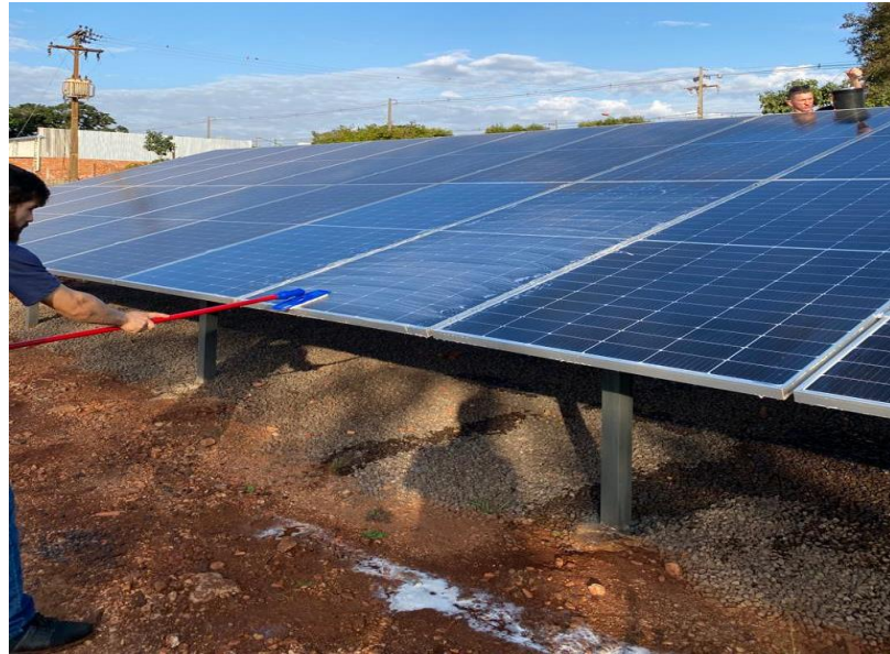
FIGURA 12 LIMPEZA MANUAL DOS MFV DA “S1”
