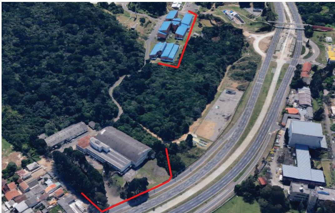
FIGURA 31 - BARREIRAS ACÚSTICAS 03 E 04 VOLTADAS PARA LINHA VERDE
