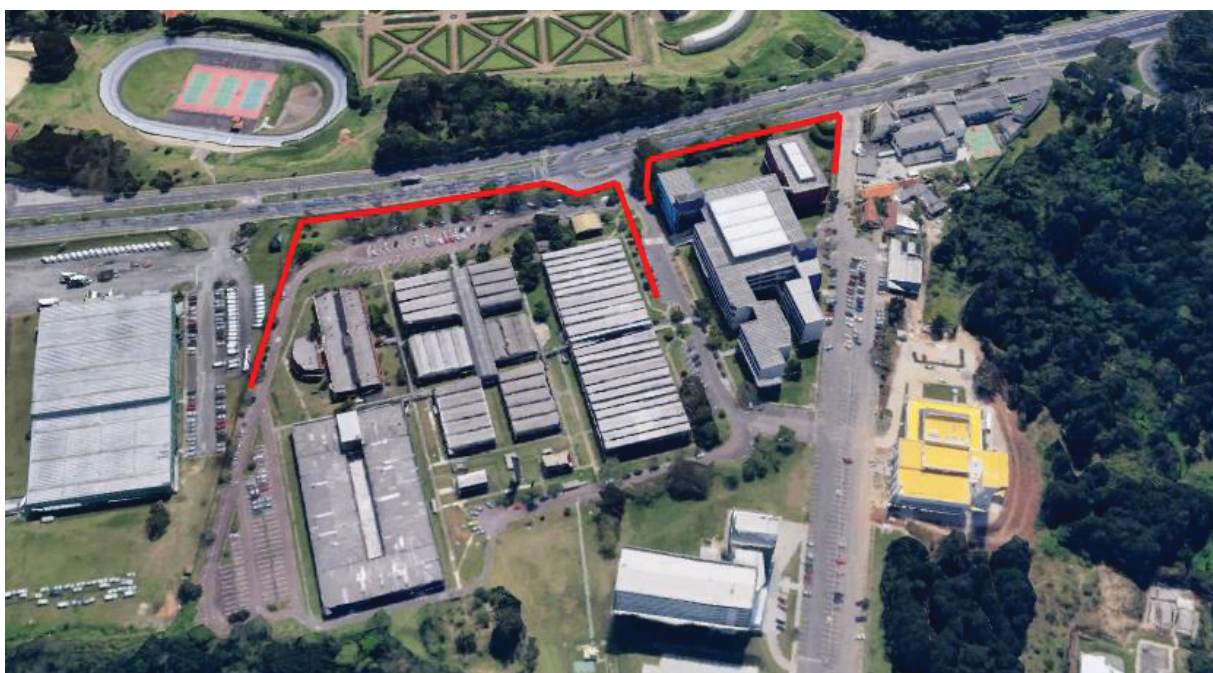
FIGURA 30 - BARREIRAS ACÚSTICAS 01 E 02 VOLTADAS PARA RUA LOTHÁRIO MEISSNER.
