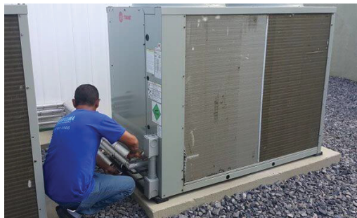
FIGURA 5 – MANUTENÇÃO DE SELF CONTAINED
