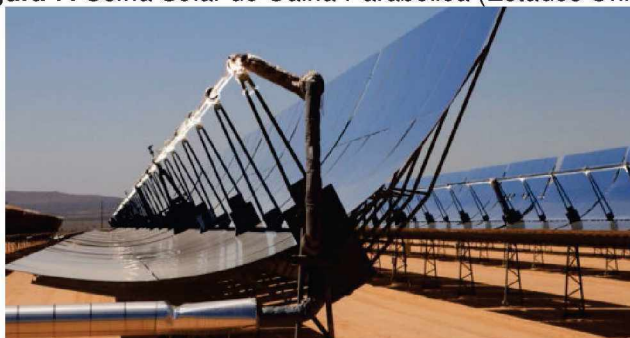
Figura 7: Usina Solar de Calha Parabólica (Estados Unidos)
