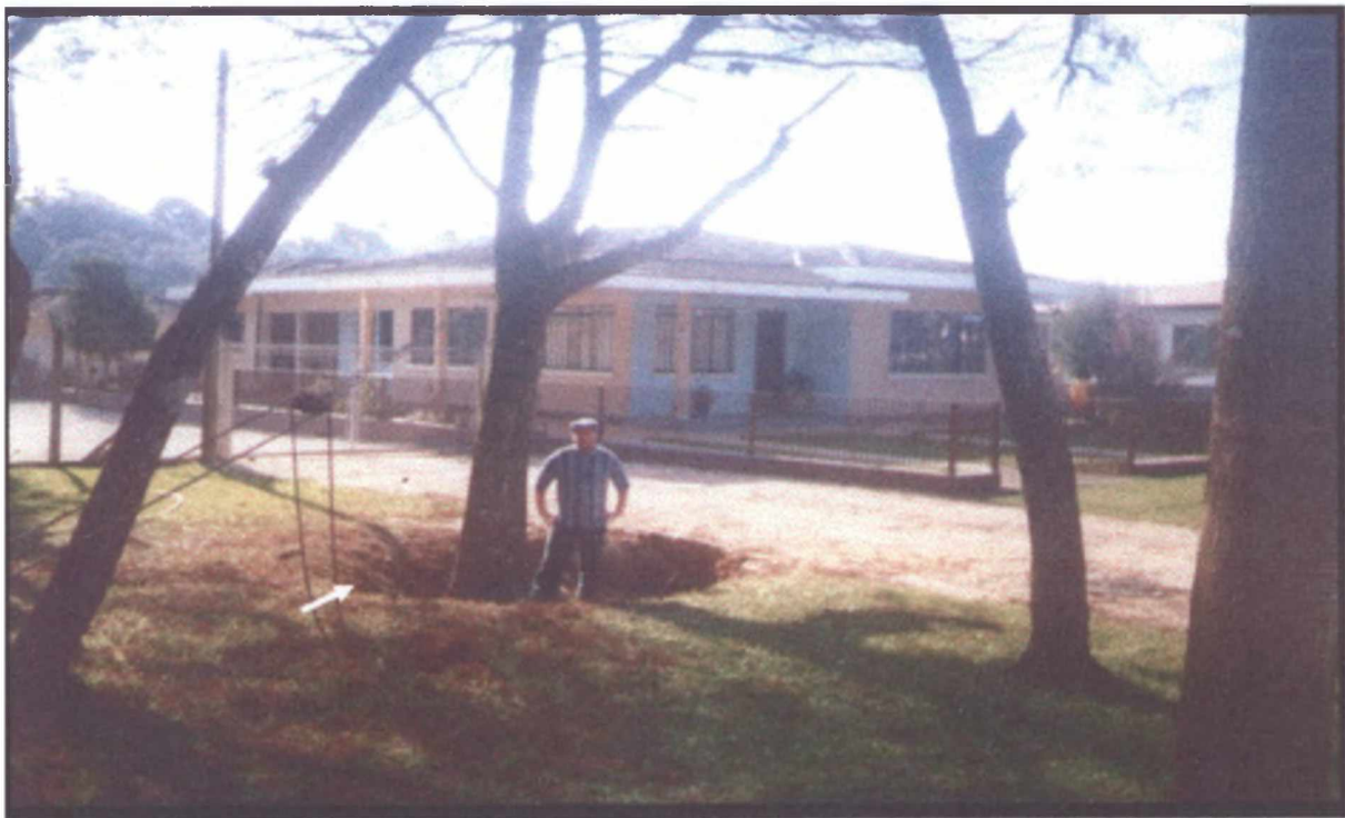
Figura 41- Colapso de Solo na Bacia do Rio Ribeirão da Onça.
