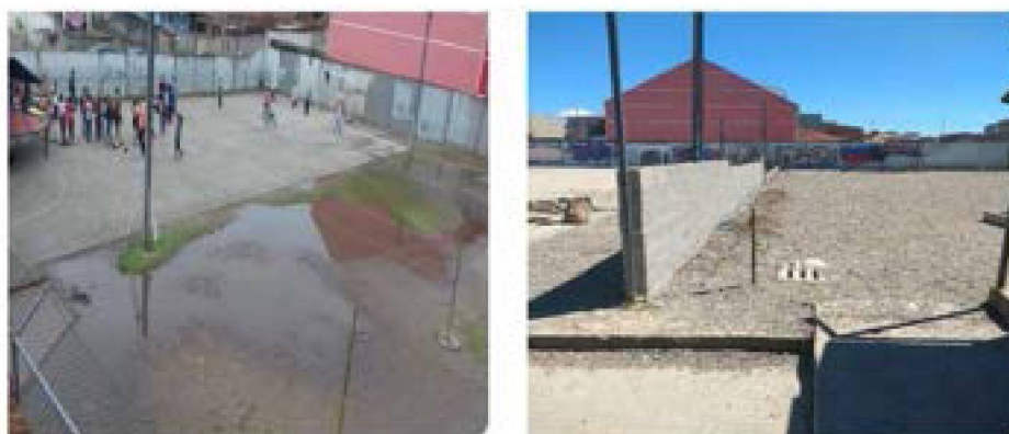
FIGURA 3 – IMAGENS DO PÁTIO ANTES E DEPOIS DO PROCESSO DE DRENAGEM
