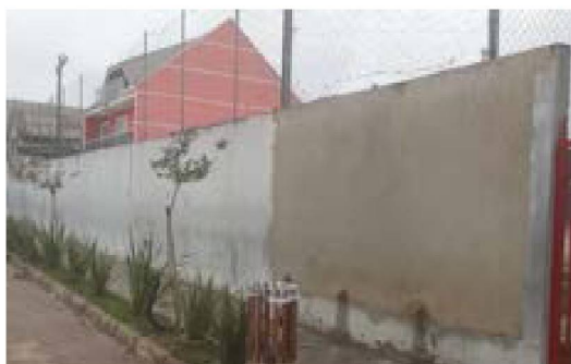
FIGURA 09 – MURO DA ESCOLA EM 2017
