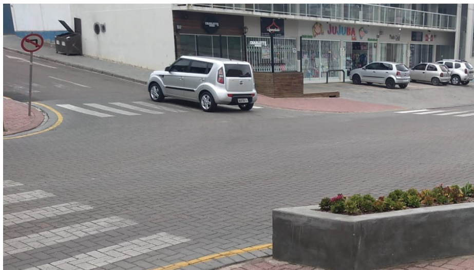
Figura 26 - Calçadas e estacionamentos em pavimentos permeáveis (Piraquara/PR)
