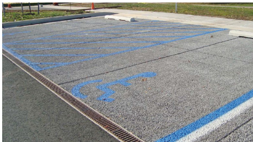
Figura 23 - Pavimento Permeável com concreto poroso
