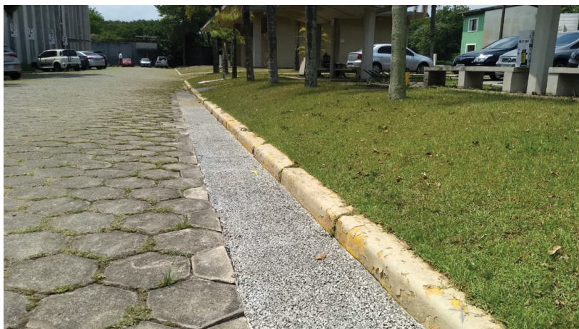
Figura 27 - Sarjeta permeável em concreto
