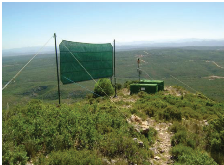
FIGURA 4 – PAINEL DE 18 M2 COM OS TANQUES RESERVATÓRIOS (ESPANHA)
