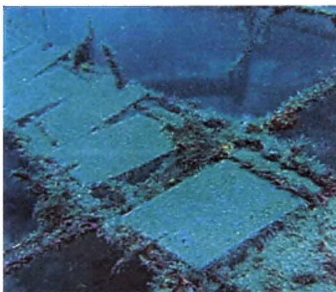
Figura 2. Estrutura experimental instalada a 18 metros de profundidade.
