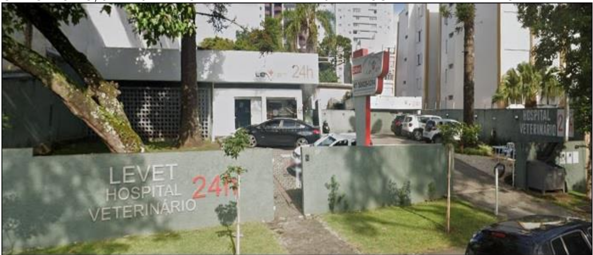
FIGURA 1 – VISTA FRONTAL DO HOSPITAL VETERINÁRIO LEVET. ESTÁGIO SUPERVISIONADO OBRIGATÓRIO, 31 DE JANEIRO À 22 DE ABRIL DE 2022 – HOSPITAL VETERINÁRIO LEVET.
