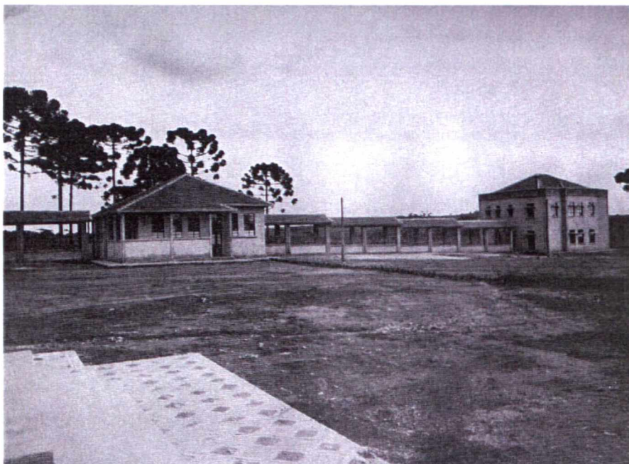
CONSTRUÇÕES DIVERSAS - (Leprosário São Roque) - PIRAQUARA
