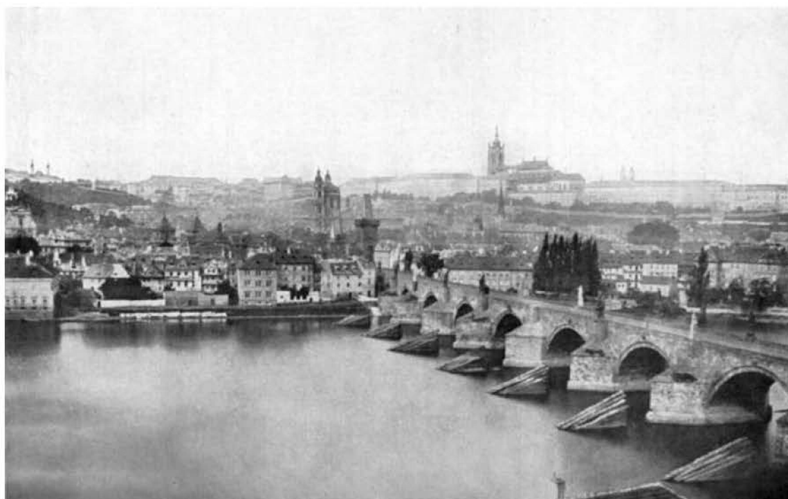
Figura 7: Panorama - Malá Strana, 1856, com Castelo e Catedral de São Vito no alto, ao fundo. 87
