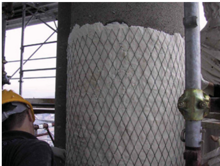
FIGURA 4 – APLICAÇÃO DA REALCALINIZAÇÃO ELETROQUÍMICA EM UM PILAR
