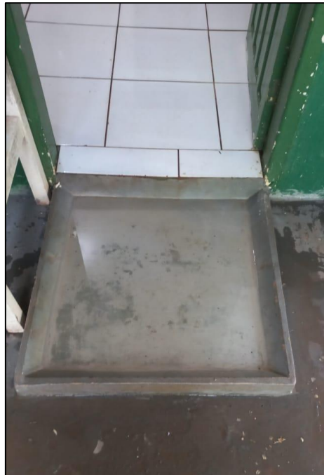
FIGURA 2: PEDILÚVIO NA ENTRADA DO BIOTÉRIO DE ROEDORES E LAGOMORFOS DO ZOOLOGICO MUNICIPAL DE CASCAVEL-PR.
