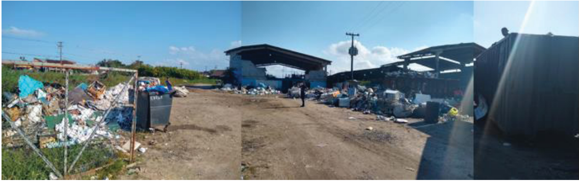
Fonte: Registro in loco realizado pela AUTORA em 2021.
