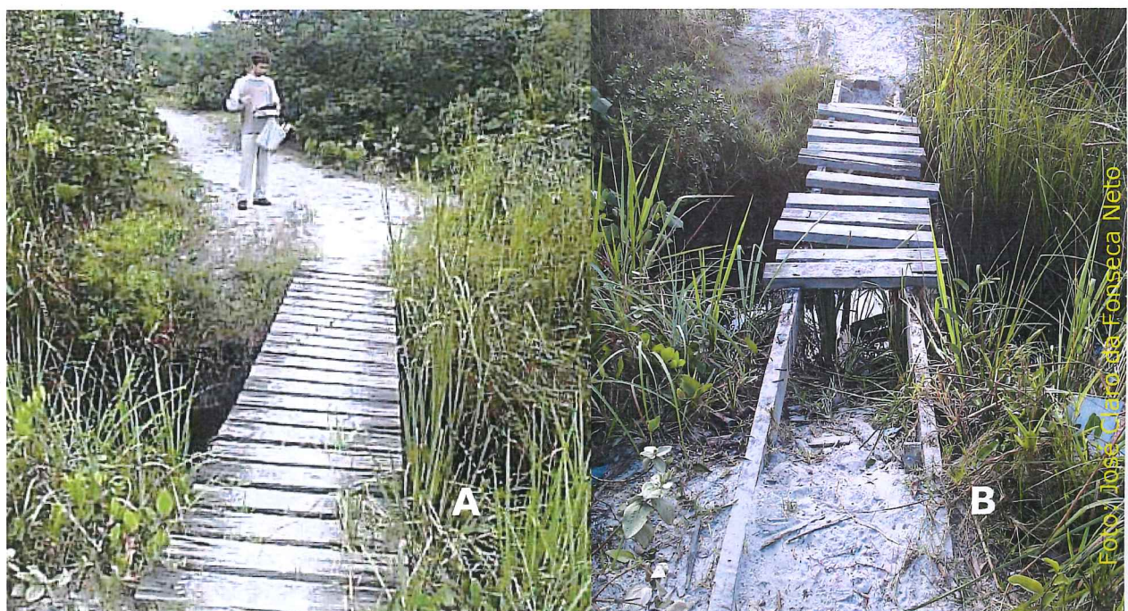
Figura 7. Fotos da primeira ponte da Trilha da Praia Deserta do Parque Nacional do Superagui, Guaraqueçaba – PR, no ponto 15. Observar a rapidez da degradação entre a coleta da pré-temporada (A) com a tirada em 5 de junho de 2005 (B). O atual estado dificulta a passagem, pode ocasionar acidentes. Foto (A): Trabalho de Campo (2005).
