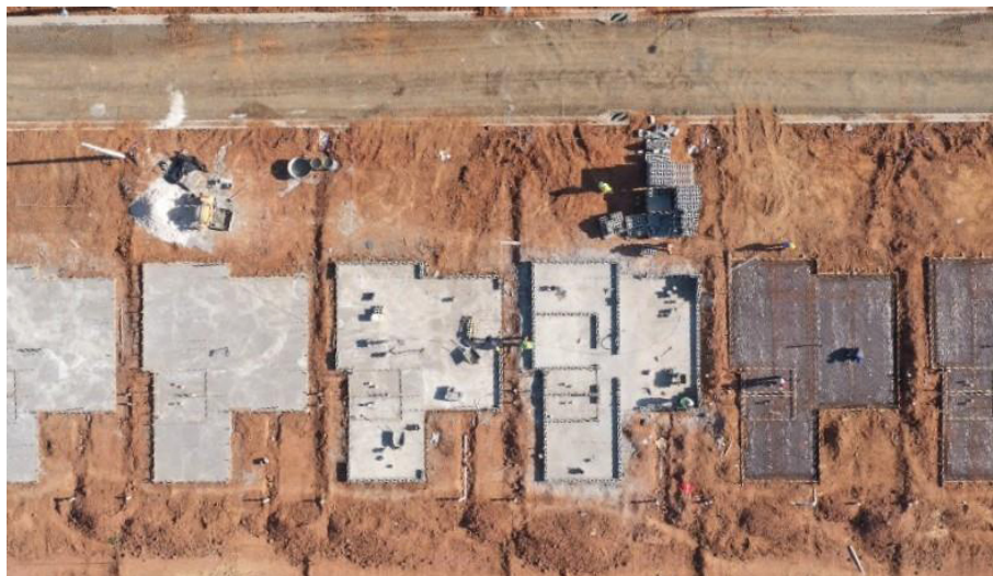
Foto 7: Detalhe para as molduras dos radiers realizadas com madeira.
