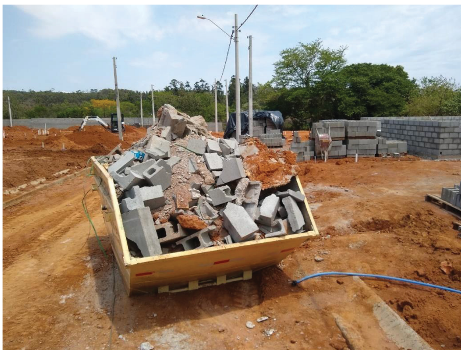
Foto 2: Caçamba repleta de resíduos inertes.
