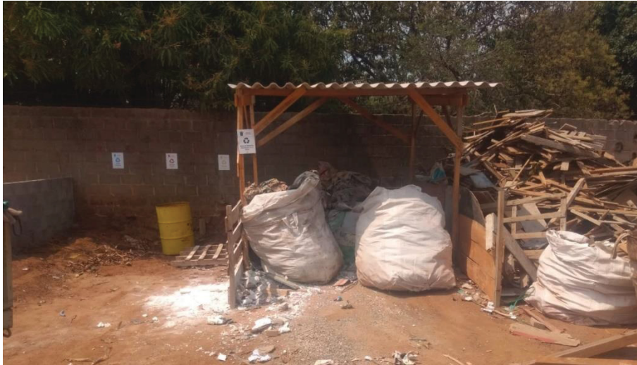
Foto 4: Baias de resíduos recicláveis.
