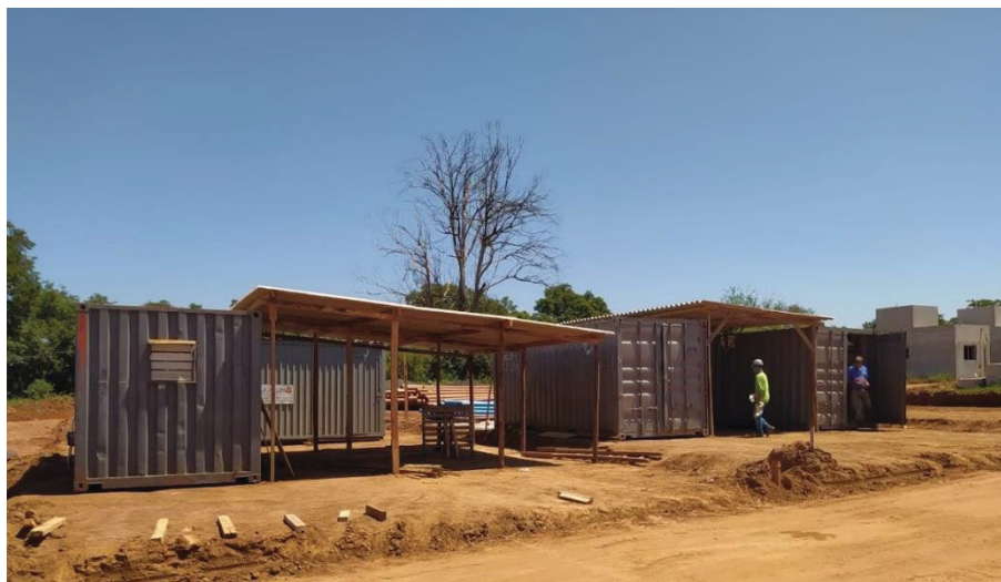
Foto 6: Canteiro de obras atual.
