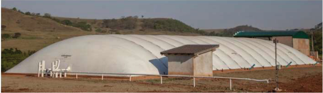
Figura 4: Biodigestor de lagoa coberta
