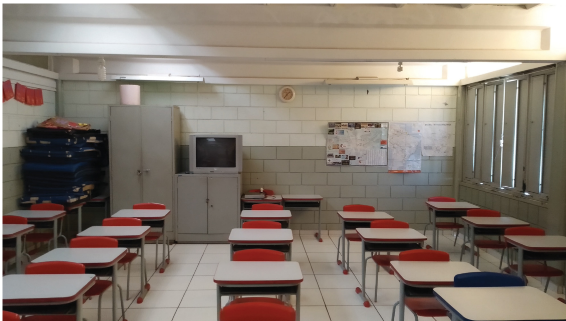
FIGURA 10 – Visão geral de uma sala de aula da escola.
