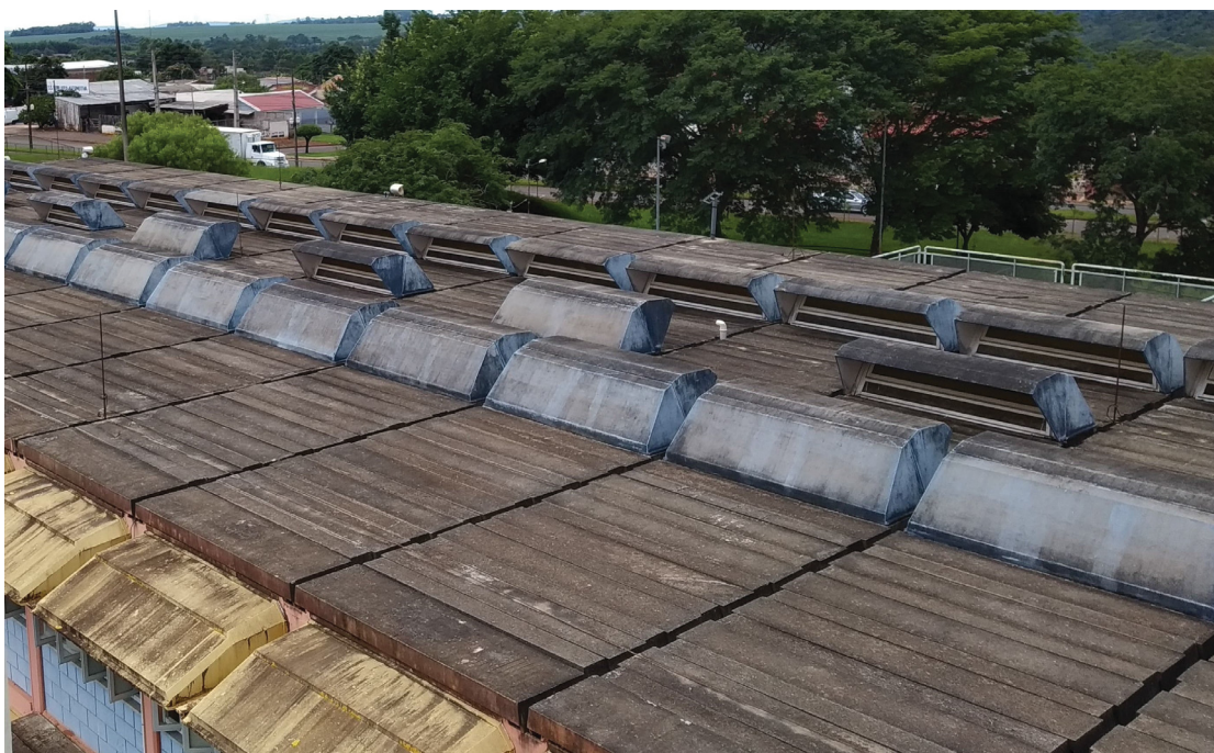
FIGURA 12 – Visão geral do teto a ser aplicada a pintura.
