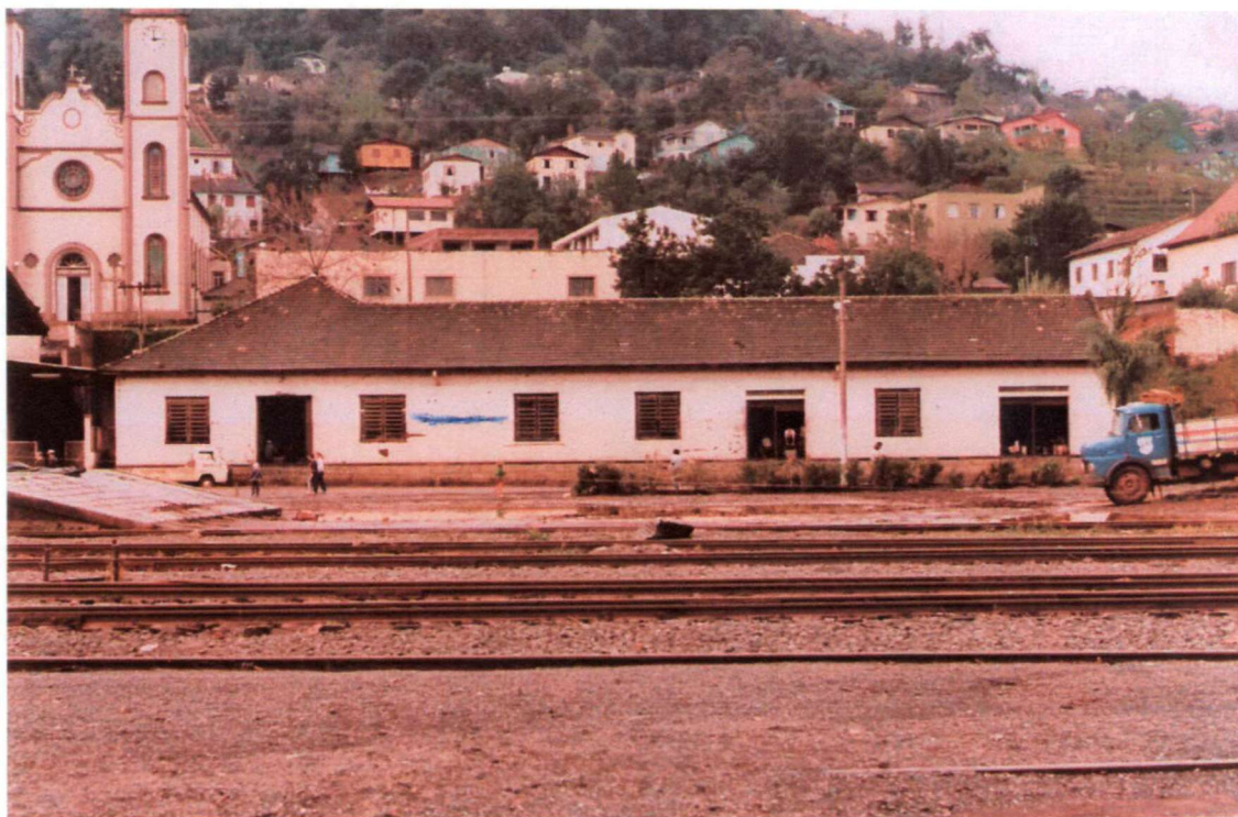
FIGURA 06 – MARCA DA ENCHENTE NO ANTIGO CHÃO FABRIL EM 1983, NÍVEL DE APROXIMADAMENTE DOIS METROS DE ALTURA.
