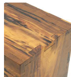
QUADRO 21 – Imagens de encaixes na madeira: empresas A e B.
