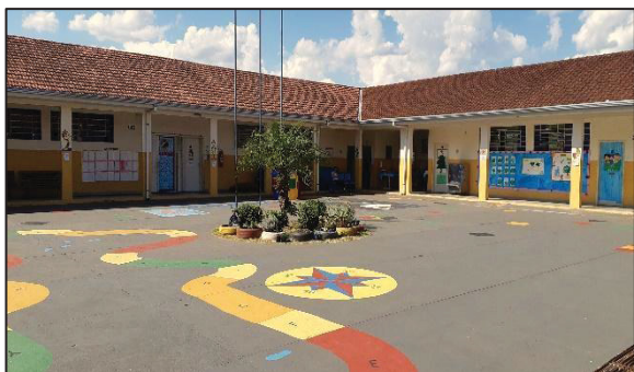
FOTOGRAFIA 01 – ÁREA INTERNA DA ETI
