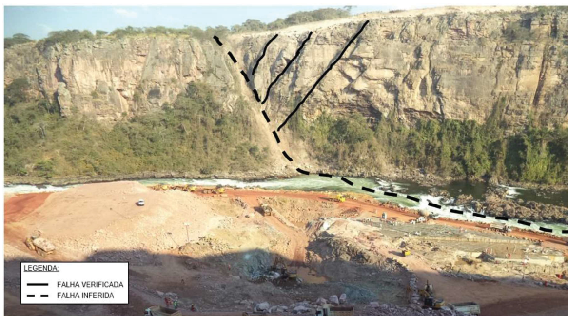
FOTO 3 – FALHA F2 NO MACIÇO DA OMBREIRA ESQUERDA
