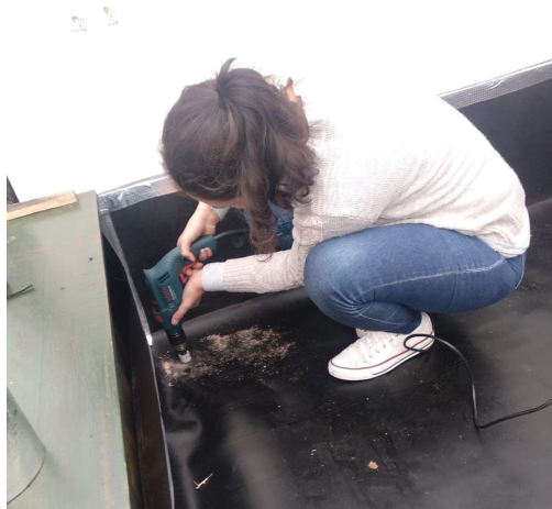
FIGURA 34 – FURO PARA ESCOAMENTO
