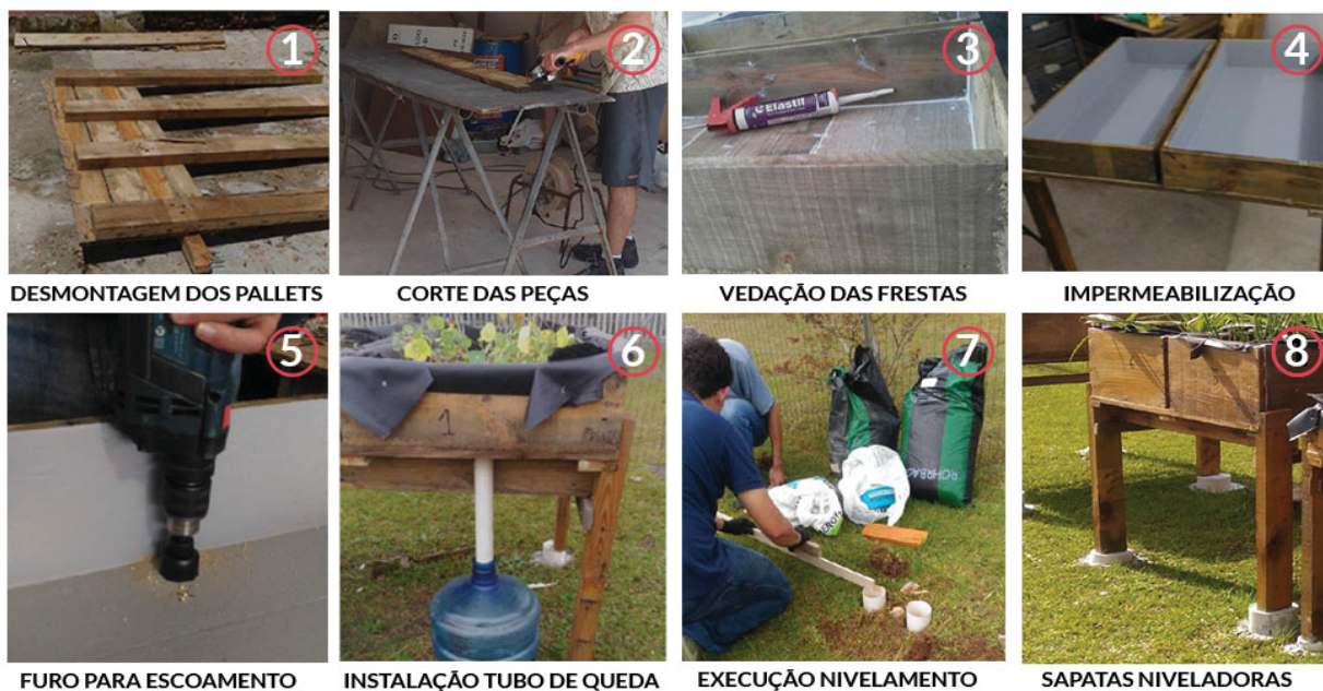
FIGURA 9- PROCESSO CONSTRUTIVO DOS PROTÓTIPOS
