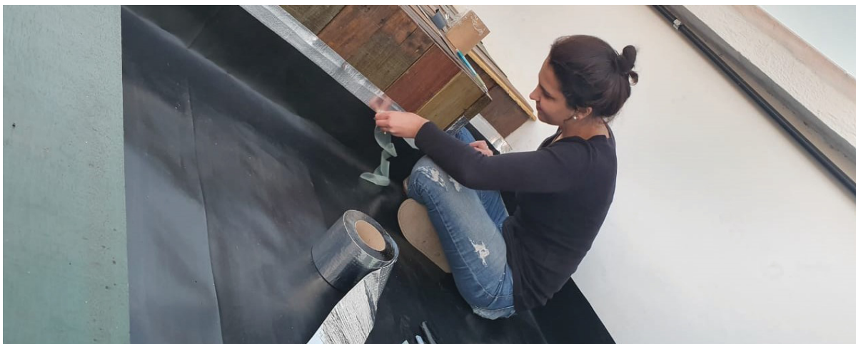
FIGURA 33 – INSTALAÇÃO DA GEOMEMBRANA DE PEAD E VEDAÇÃO DAS EMENDAS COM FITA IMPERMEABILIZANTE
