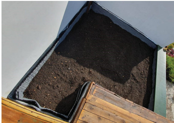
FIGURA 36 - SUBSTRATO NOS CANTEIROS
