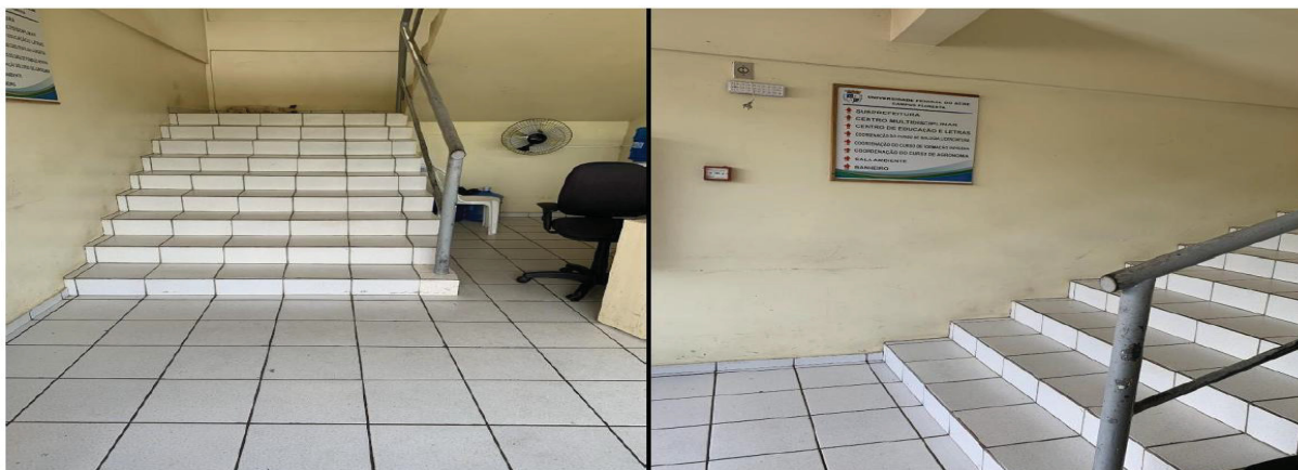
FIGURA 15 - ESCADA DE ACESSO AO 2º PISO DO PRÉDIO ADMINISTRATIVO DO CAMPUS FLORESTA
