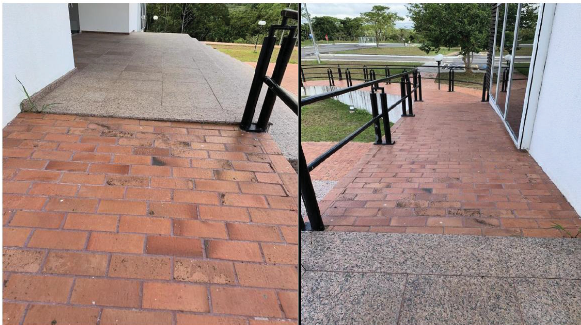
FIGURA 17 - RAMPA DE ACESSO AO TEATRO DO CAMPUS FLORESTA
