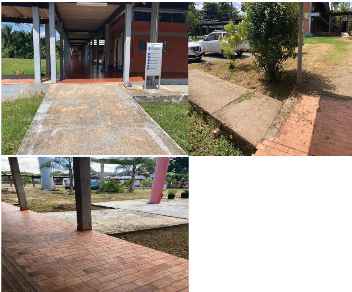
FIGURA 8 - DESNÍVEIS NO ENCONTRO ENTRE PASSARELAS E CORREDORES NO CAMPUS SEDE
