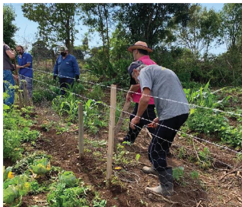
FIGURA 12 – REALIZAÇÃO DA MANUTENÇÃO
