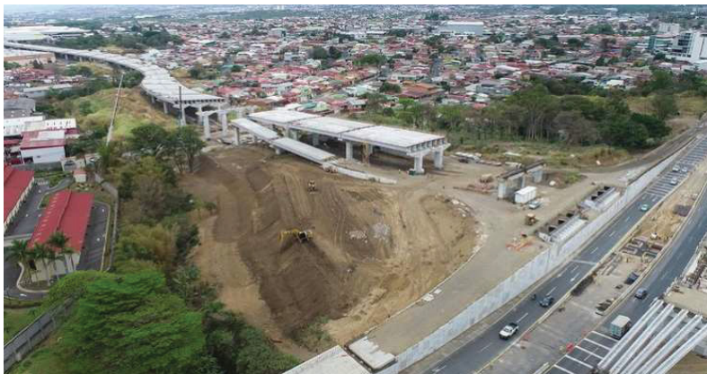
Figura 10 – Construção de um viaduto na Costa Rica
