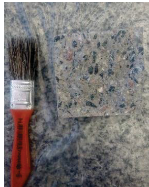
b) Remoção do material solto
