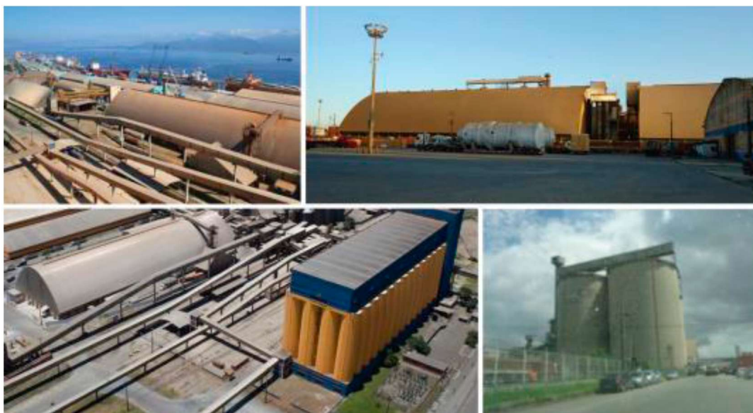
FIGURA 4 – SILOS DO PORTO DE PARANAGUÁ
