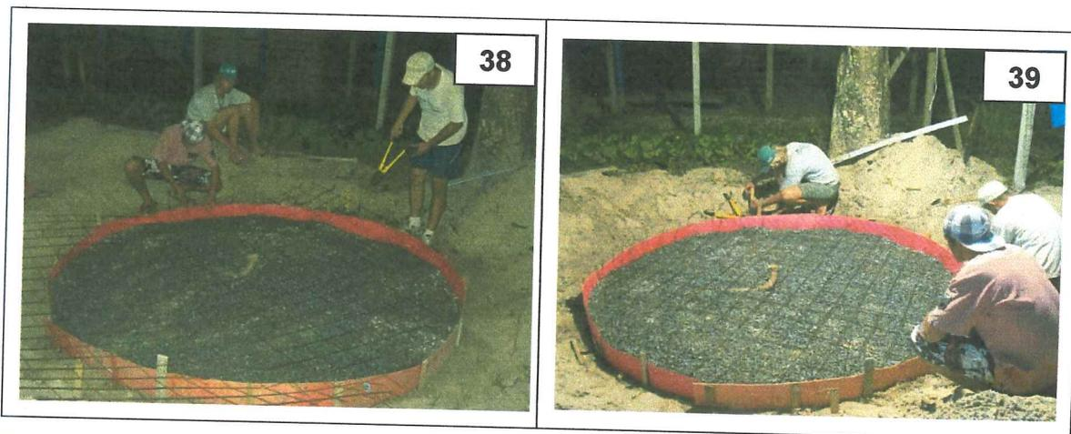
FIGURAS 38 E 39 – RECORTE DA MALHA DE FERRO ESTRUTURAL PARA O PISO. FONTE: O AUTOR, 2011.
