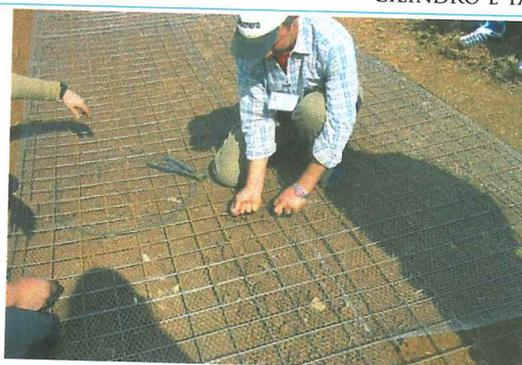
5. Fixação da tela na malha de ferro (parede lateral)
