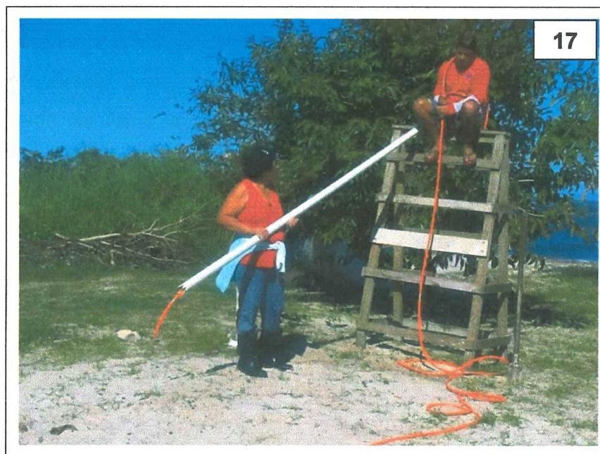
FIGURA 17 – INSTALAÇÃO DA PONTEIRA PARA BOMBEAMENTO DE ÁGUA NÃO POTÁVEL. FONTE: O AUTOR, 2011.
