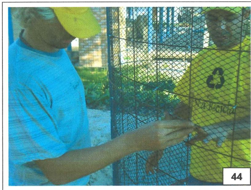
FIGURA 44 – REFORÇO DO CILINDRO COM VERGALHÃO 5mm. FONTE: O AUTOR, 2011.
