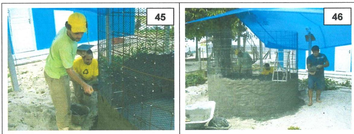
FIGURAS 44 E 45 – REVESTIMENTO PELO LADO EXTERNO DO CILINDRO. FONTE: O AUTOR, 2011.
