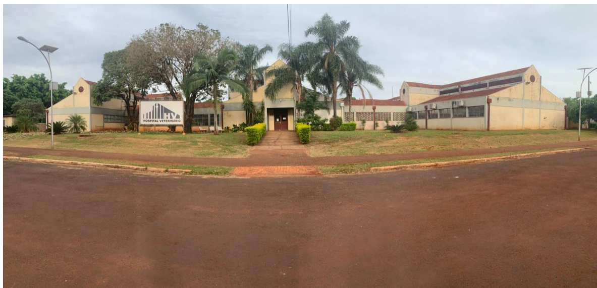
FIGURA 1 – FACHADA DO HOSPITAL VETERINÁRIO PALOTINA DA UNIVERSIDADE FEDERAL DO PARANÁ. ESTÁGIO OBRIGATÓRIO, 25 DE AGOSTO A 26 DE NOVEMBRO DE 2021.
