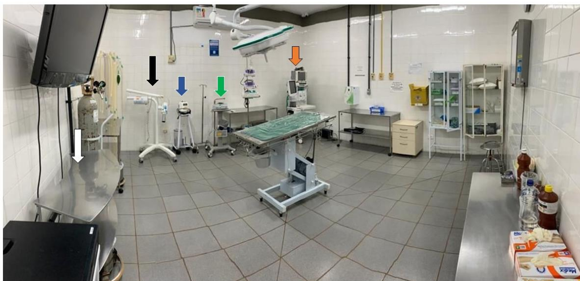
FIGURA 10 – CENTRO CIRÚRGICO DO HOSPITAL VETERINÁRIO PALOTINA DA UNIVERSIDADE FEDERAL DO PARANÁ. ESTÁGIO OBRIGATÓRIO, 25 DE AGOSTO A 26 DE NOVEMBRO DE 2021.
