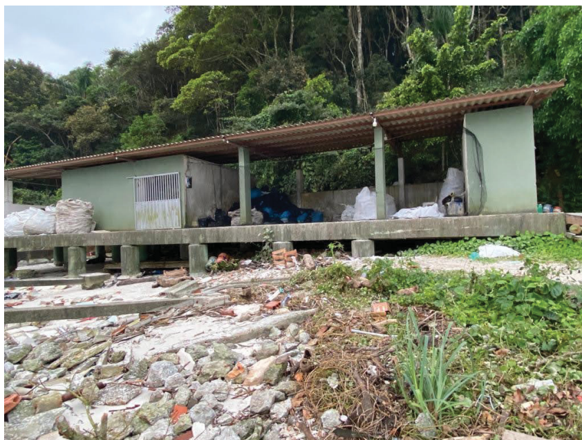
Figura 38 - Estação de transbordo localizada na vila de Encantadas
