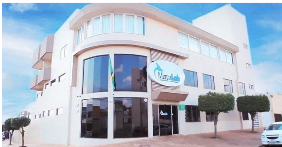
FIGURA 1- VISTA FRONTAL DO MERCOLAB
