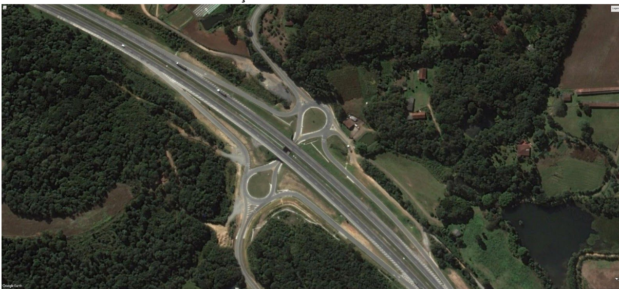
FIGURA 10: IMAGEM DE 2013 - APÓS A CONSTRUÇÃO DO TREVO DE ACESSO À RODOVIA E PAVIMENTAÇÃO DA ESTRADA DA GRACIOSA.
