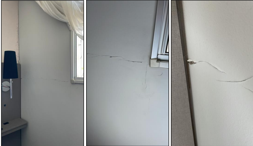
FIGURA 20 – PAREDE DA JANELA NA SUÍTE
