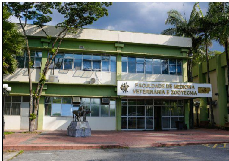
FIGURA 17 – Fachada da Faculdade de Medicina Veterinária e Zootecnia - USP.
