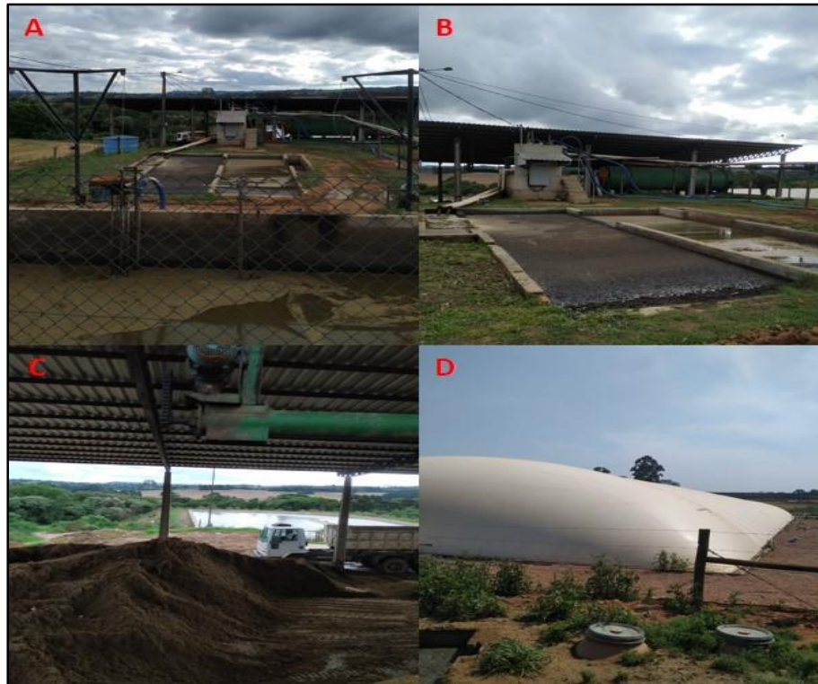
FIGURA 9 – Área de separação de dejetos (A) com tanques para separação da parte sólida e líquida (B). Dejetos sólidos a ser destinado para adubação agrícola (C) e biodigestor (D).
