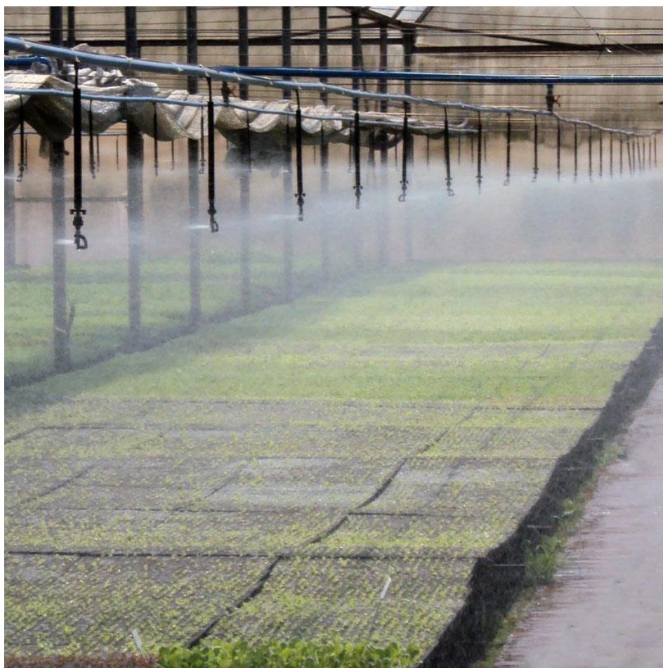
FIGURA 11 : Sistema de irrigação das estufas
