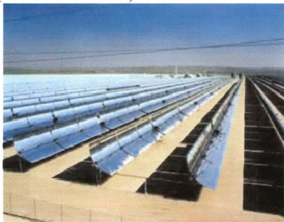
FIGURA 4 - SISTEMA TÉRMICO DE GERAÇÃO SOLAR DE ENERGIA ELÉTRICA (CALIFÓRNIA - EUA)
