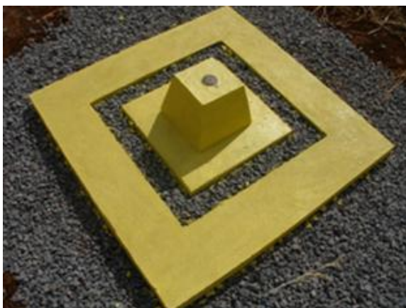
FIGURA 11. VISTA PANORÂMICA DO MARCO GEODÉSICO DEVIDAMENTE FINALIZADO.
